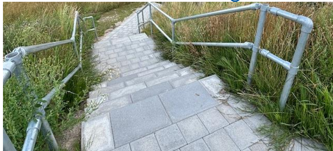
Ny trappe ved Båstrupvej
