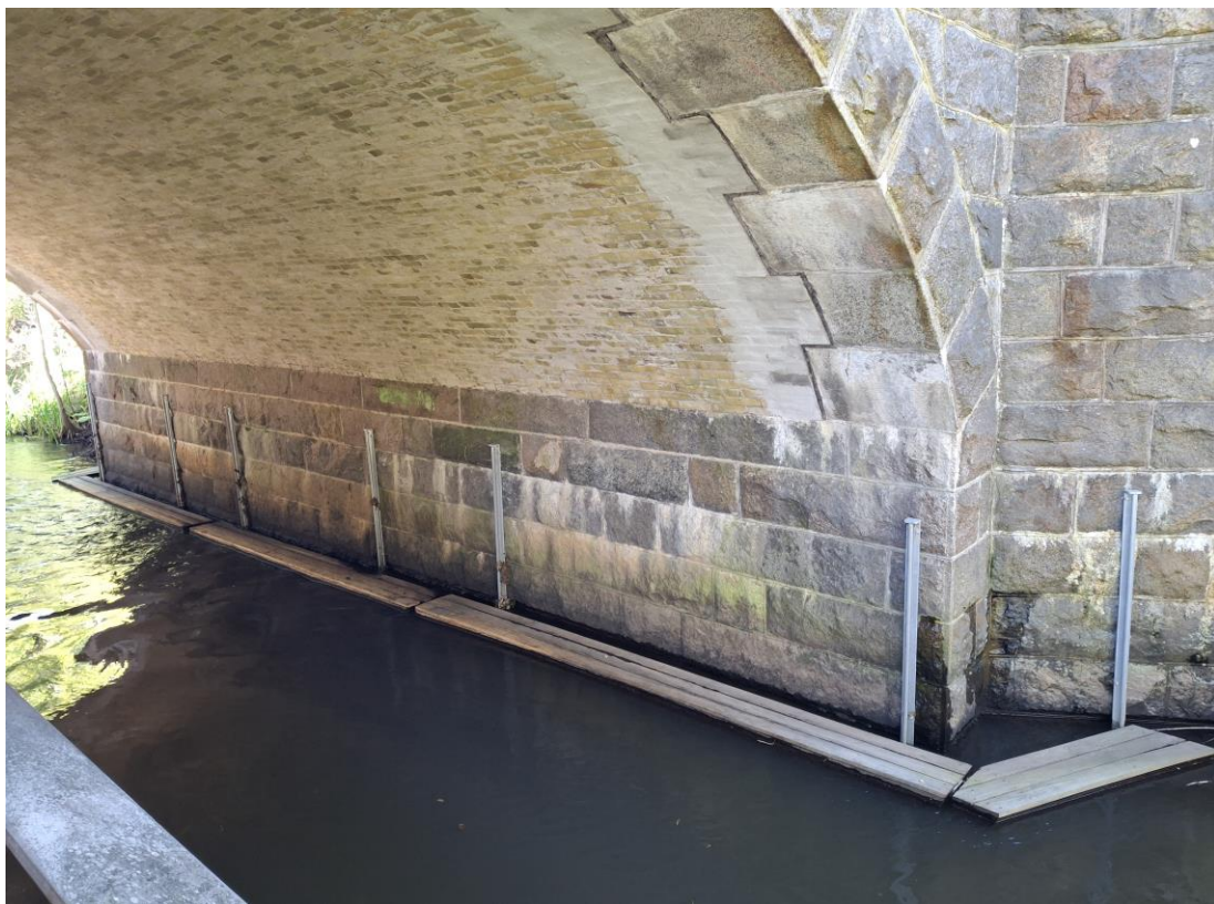
Øverst en pontonbro ved kystbanen og th. Passage ved motorvejen.
