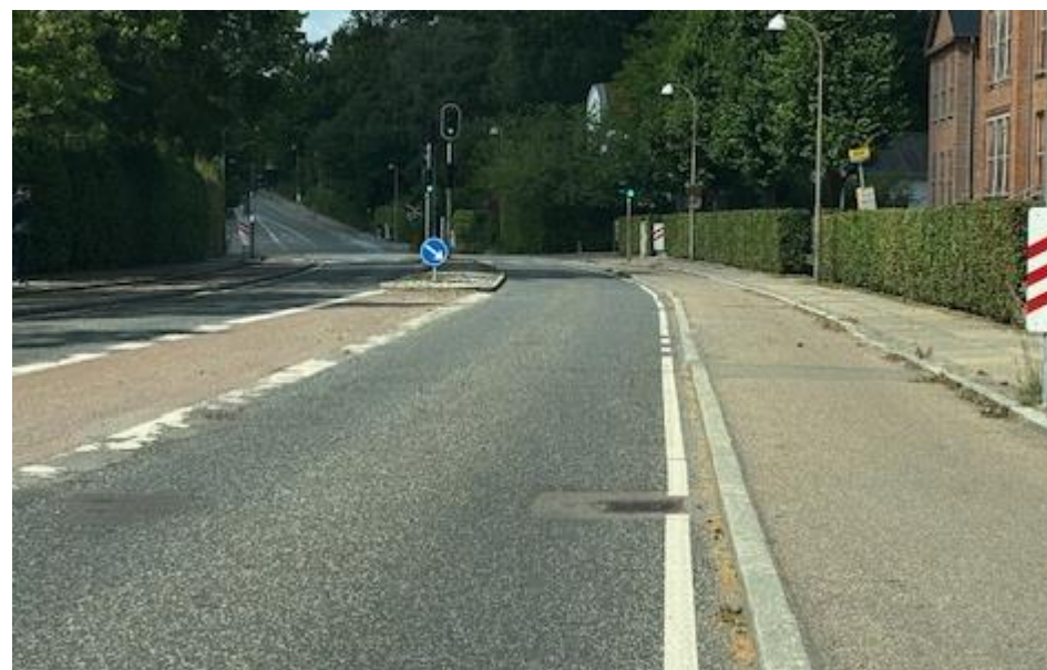
Trafiksanering og cykelsti langs Benediktevej
