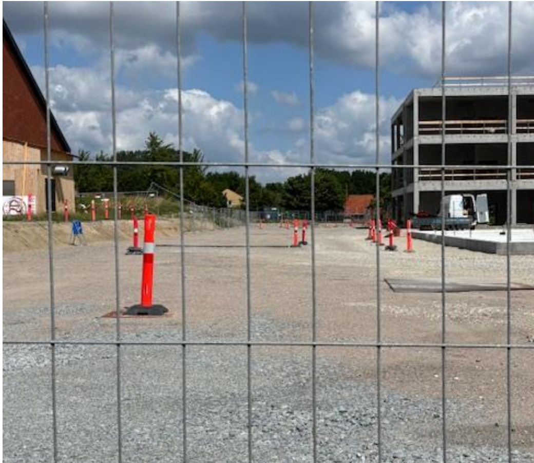
Råveje i Nivå bymidte pågår
